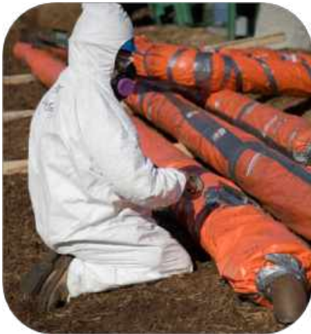
عامل يرتدي جهاز تنفس نصف قناع لخم الأسبستوس المغلف للأنبوب
