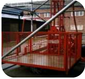
مصعد لرفع المواد إلى أعلى وإنزالها خلال العمل على السطح
