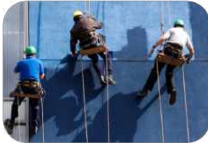
كرسي الريان يستخدم لعملية الصباغة
