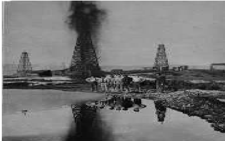
شكل (2.10). حادث انفجار وتسريب النفط في بئر ليكفيو بالولايات المتحدة، المصدر: (عالم النفط والغاز، 2018م)
