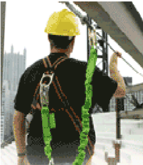
شكل (٧-٣٣) : معدات منع السقوط من السلالم والاماكن المرتفعة .
