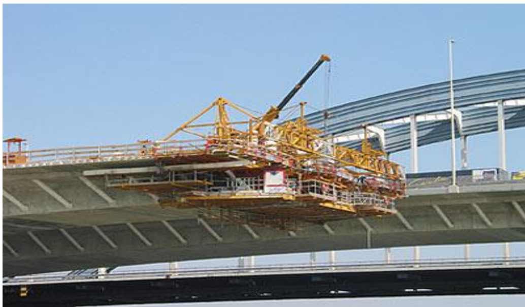
:Cantilever falsework
