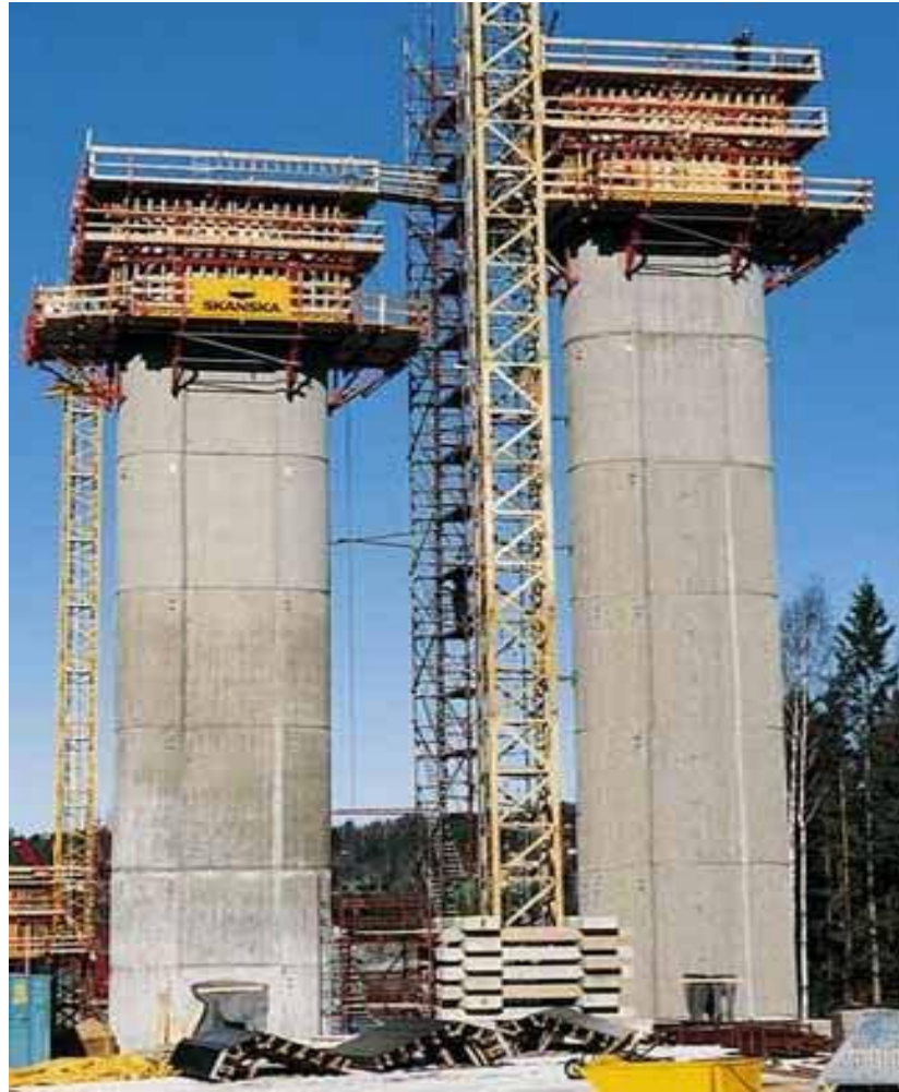
:Cantilever falsework
