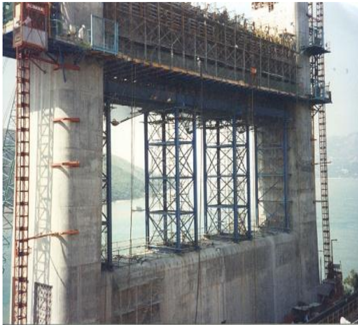
Sliding falsework- شدة منزلقة ( متحركة رأسيا ) و تستخدم في عمل ركائز الكوبري piers
