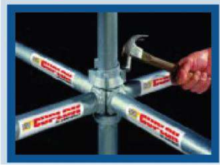
٢ / بعد تثبيت الأنابيب داخل نصف الكوب الأسفل يتم إنزال نصف الكوب الأعلى
