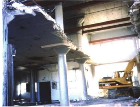
شكل رقم (٧/١٣) الهدم بواسطة الحفار
