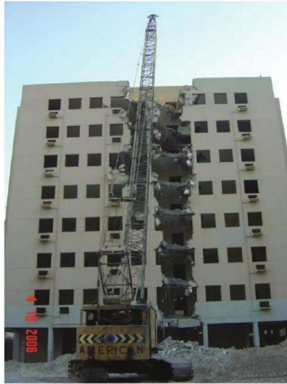
شكل ( رقم ١٠/١٣ ) الهدم باستخدام الكرة
