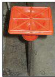
حديد التسليح وقد تمت تغطية أطرافه الدبية - Capped Rebar شكل رقم (٤)
